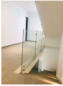
Escaleras con barandil de vidrio templado Stairs with tempered glass rails
