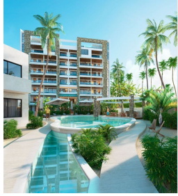
Edificio y alberca Building & pool
