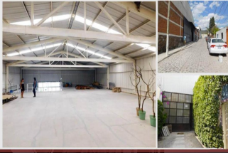
Bodega Santa Rosa Jáuregui
